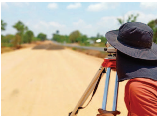
Gambar 4.2 Menggunakan Theodolit
